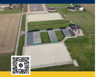
Bei unseren Ebbe & Flut Premium Reitplätzen setzen wir auf Qualität, Stabilität und Langlebigkeit. Die klassische Filterschicht aus Sand wird durch gebrochene Lava ersetzt, und die Drainagerohre werden in Gräben verlegt.
